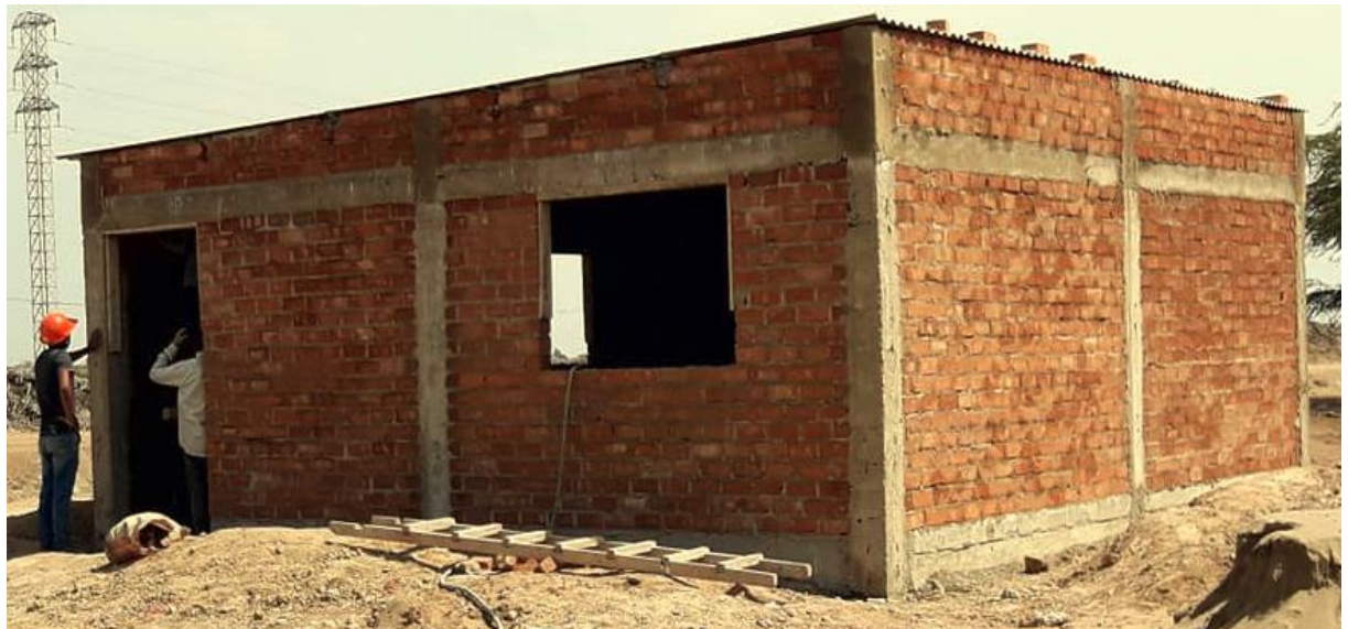
Das neue Gebäude im Rohbau
