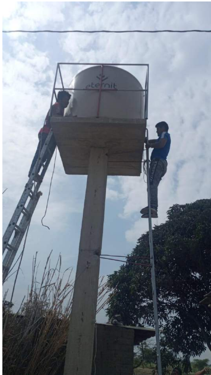
Proyecto: Construcción de pozo para el sector Los Morales – Sialupe Baca.
