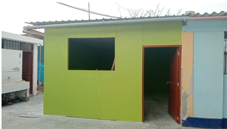
Construcción de aula escolar I.E. Agustín Gavidia – Pueblo Nuevo
